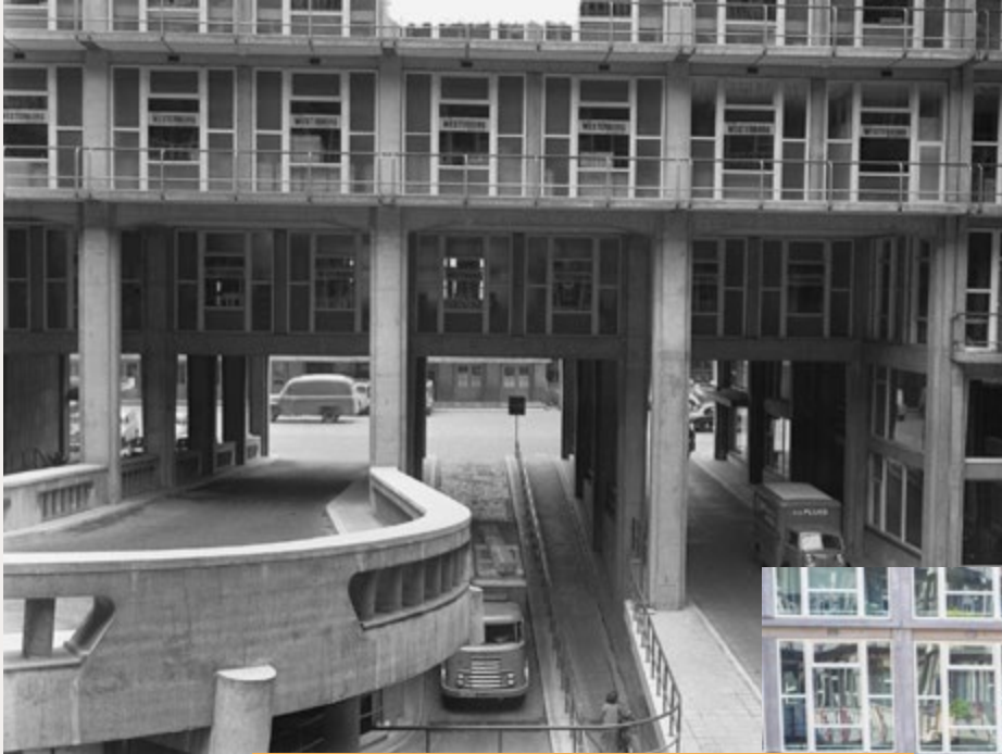
GROOT HANDELSGEBOUW / Rotterdam, Netherlands
